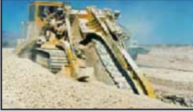
KANAL KAZI VE KABLO SERME ESNASINDA
